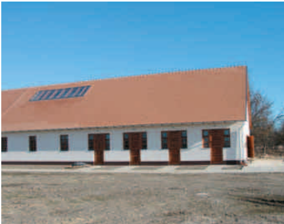
Abb. 25: Das Besucherzentrum und Museum ist fast fertig gestellt. The visitor centre and museum has nearly been completed.
