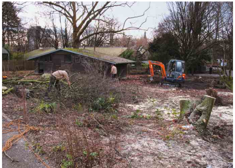
Abb. 79: Im Januar 2012 wurde die Baustelle für das neue Ameisenbärgehege gerodet. In January 2012 we cleared the building site for the new giant anteater enclosure.
