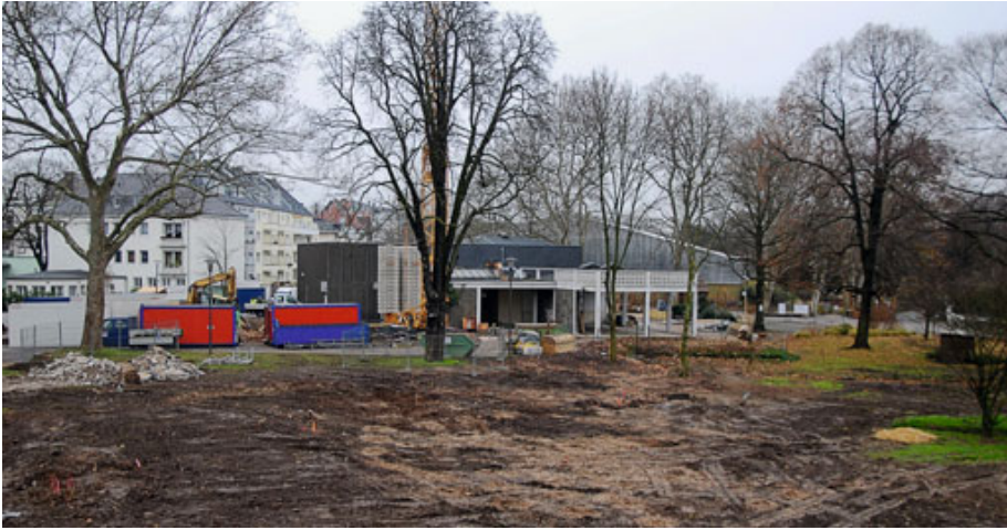
Abb. 4: Hier entsteht der „Clemenshof“, ein Bauernhof mitten in Köln. Im Hintergrund das entkernte Gebäude der Zoogastronomie, die komplett saniert wird.
