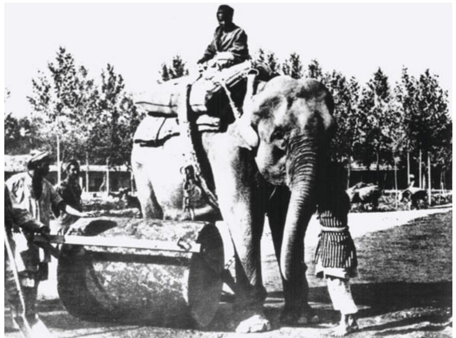
Abb. 6: Der Einsatz eines Elefanten im Straßenbau 1915.
