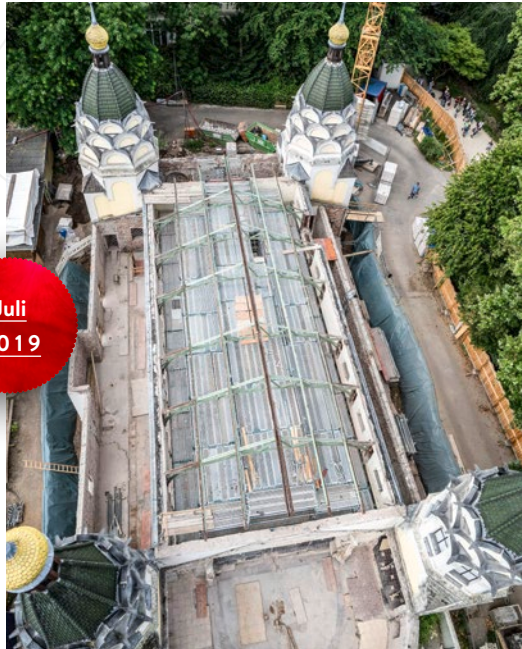
Blick von oben auf das entkernte und vom Dach befreite Haus.
