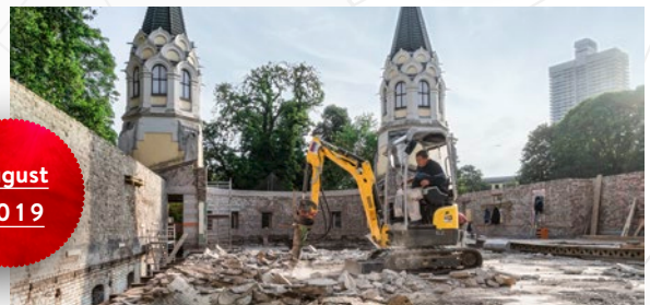
Innenansicht des entkernten Hauses. Beginn des Abbruchs der Bodenplatte.
