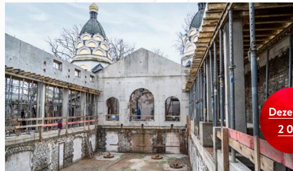
Die Fundamente für die Pflanztröge werden sichtbar. Giebelwand und Obergaden sind bereits rekonstruiert.
